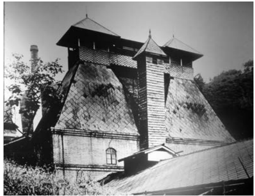
建設当初の山崎工場麦芽乾燥室
