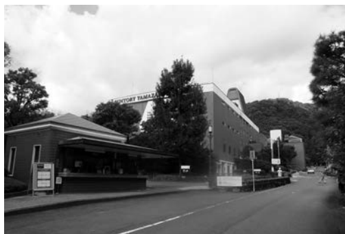
現在の山崎蒸溜所
